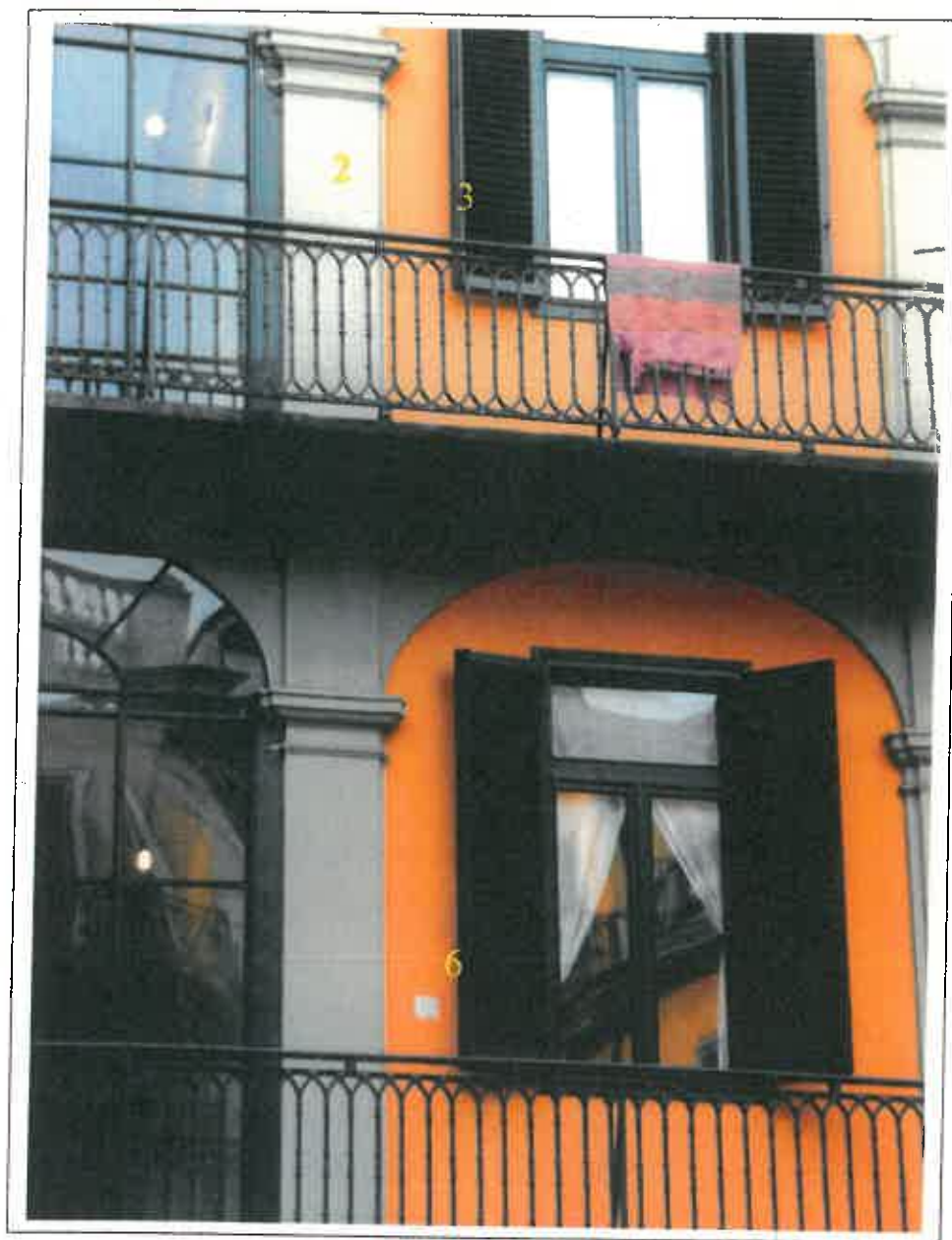
Foto 4 Edificio su Via Verdi facciata interno cortile con l'ubicazione dei tasselli .
