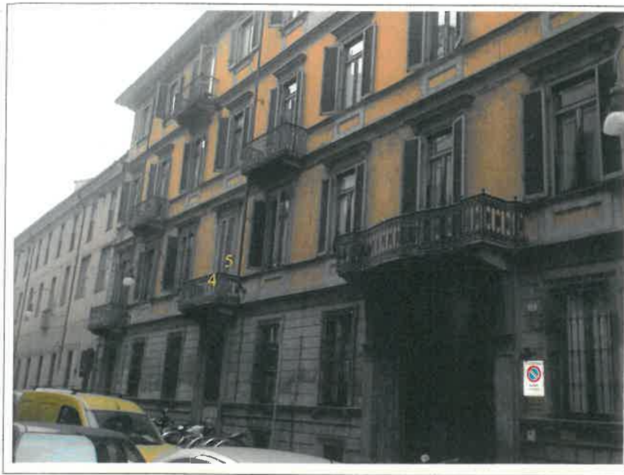
Foto 2 Prospetto su Via Verdi con l'ubicazione dei tasselli.
