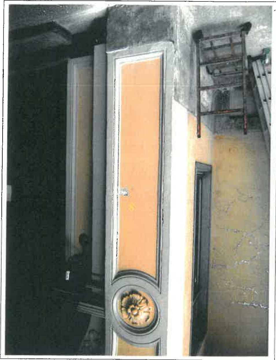
Foto 6 Lesena d'ingresso fondo cortile (lato destro) con l'ubicazione dei tasselli.
