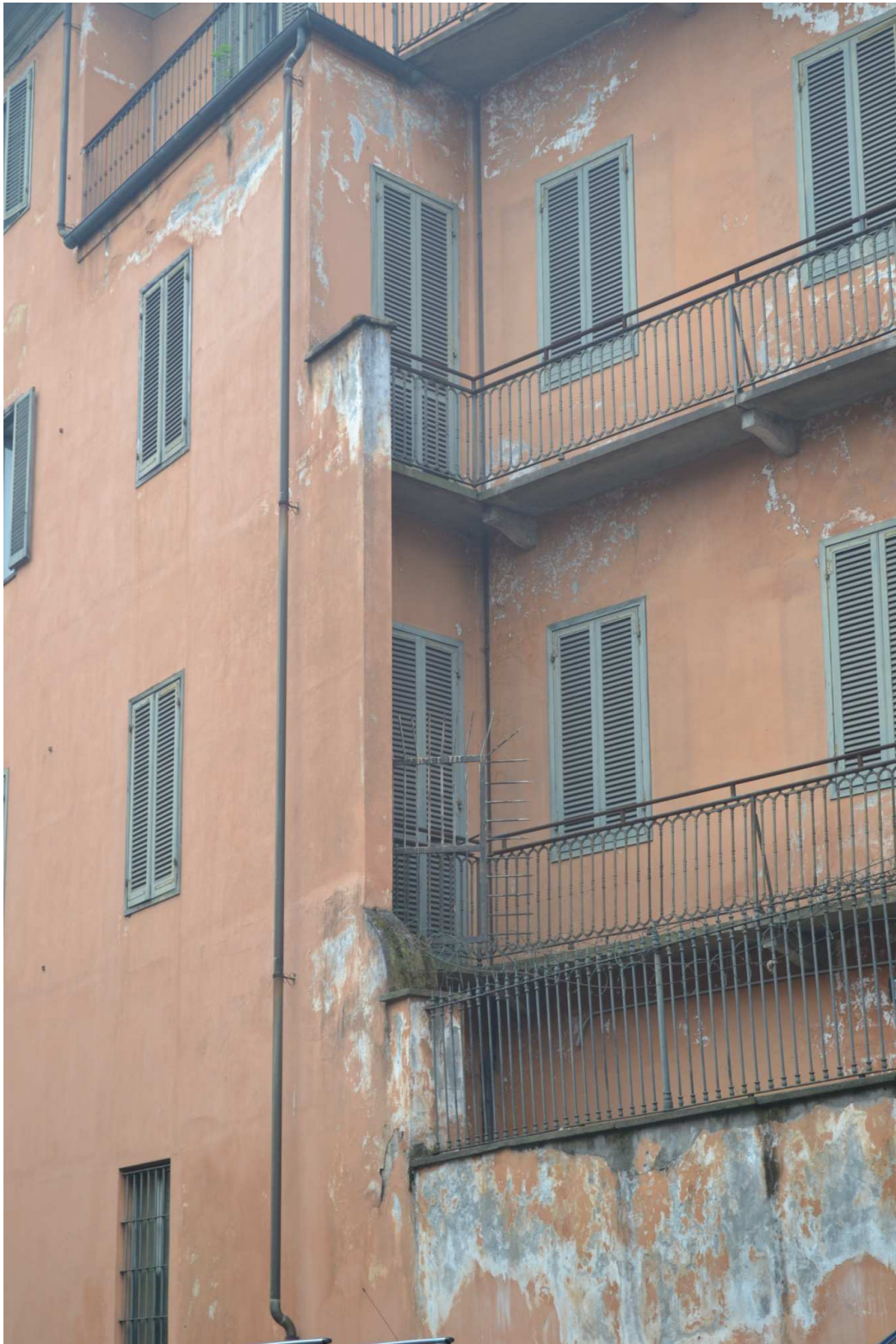
PROSPETTO NORD VERSO LA CAVALLERIZZA – PARTICOLARE DI FACCIATA
