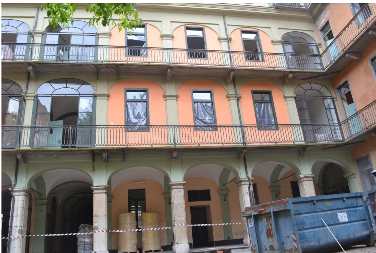
PROSPETTO SUD- CORTILE INTERNO – VISTA DEL PORTICATO
