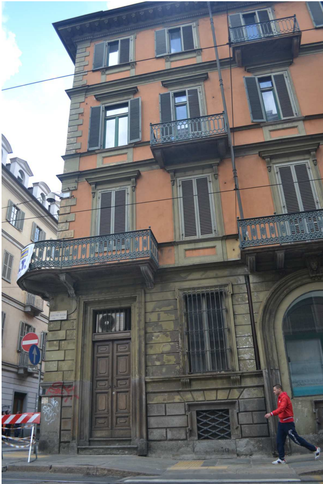
PARTICOLARE DELLA FACCIATA SU VIA ROSSINI – STRISCIATA VERTICALE DEL PROSPETTO
