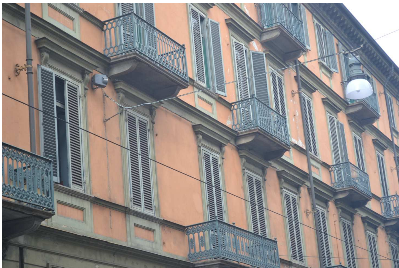
PARTICOLARE DELLA FACCIATA SU VIA ROSSINI – 1°-2°-3° PIANO
