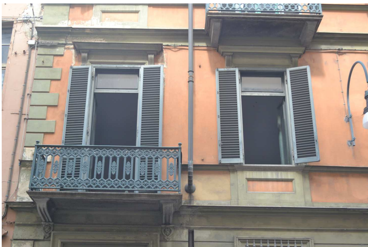
DETTAGLIO DELLA FACCIATA SU VIA VERDI - 1° PIANO
